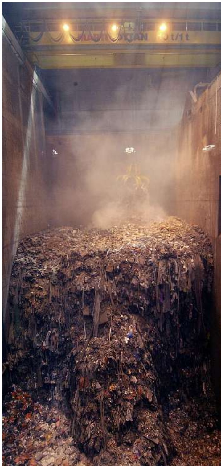
Der Kehrichtbunker in der KVA Thun: Strom und Wärme, die aus dem Ghüder hergestellt werden, sind wichtiger Pfeiler der regionalen Energieversorgung.
